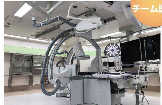
高性能なX線診断装置と手術台を設置し、外科的手術と血管内治療を同時に行なうことができるハイブリッド手術室事例
