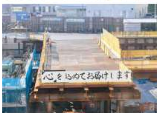
工事現場中央に置かれた手作りメッセージ
