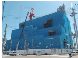
令和8年6月時点の工事進捗状況
