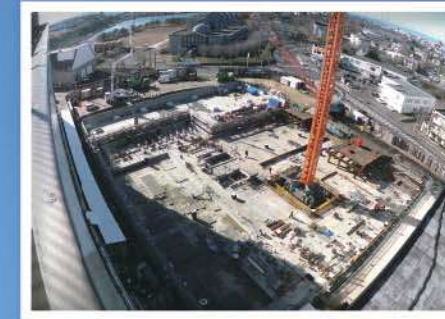
令和7年11月現在の工事進捗状況
